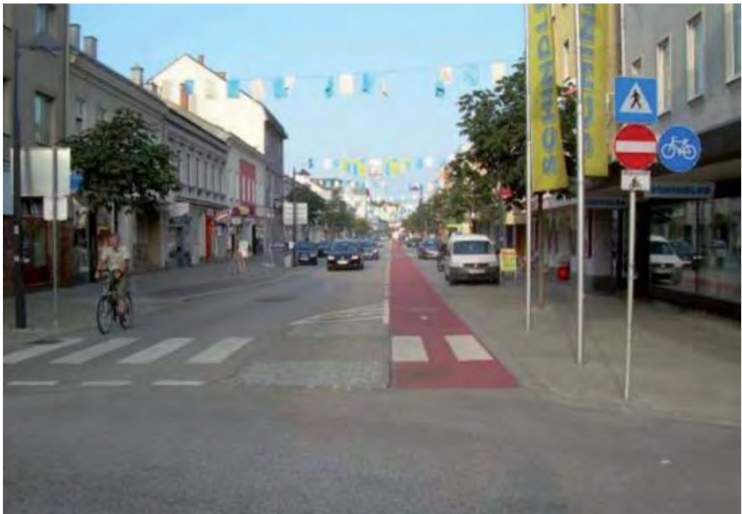
Abbildung 61: Best Practice Beispiel für eine optimale Bodenmarkierungs-Lösung abseits von Knotenpunkten: Baulich getrennter Beginn eines farblich hervorgehobenen Radfahrstreifens gegen die Einbahn neben Parkstreifen (Quelle: FSV 2014)
